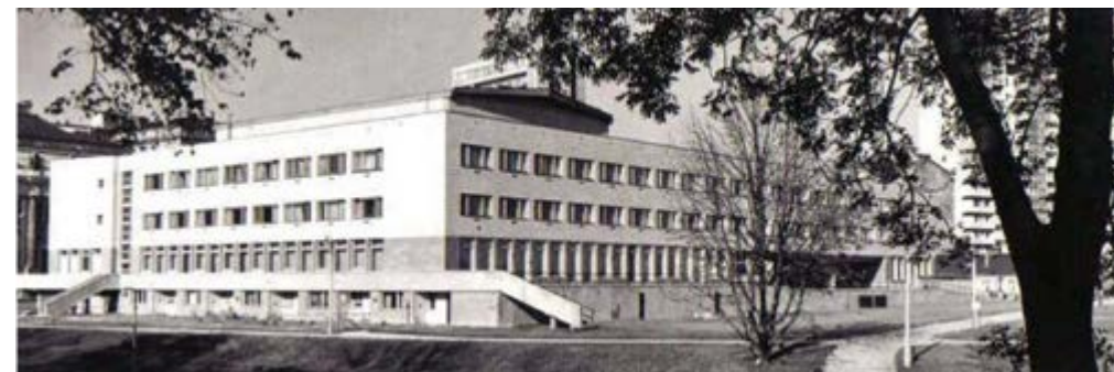
Nowy gmach PWSM przy ul. Okólnik 2, zaprojektowany przez Witolda Benedeka, Stanisława Niewiadomskiego, Stefana Sienickiego, Władysława Strumiłłę i Zbigniewa Michejdę (1960-1966). | The new PWSM building at Okólnik Street, designed by Witold Benedek, Stanisław Niewiadomski, Stefan Sienicki, Władysław Strumiłło and Zbigniew Michejda (1960-1966). źródło: zbiory własne UMFC
